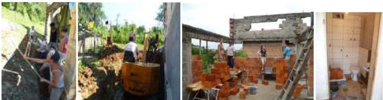
Vlnr. De achterwand vrij gegraven (2x); de bouw vordert; de nieuwe badkamer is bijna klaar.
