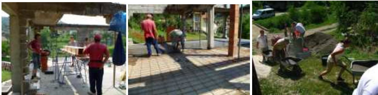
Vlnr: voorbereidingen voor de pilaar. Storten van de vloer incl. bewapening. Cement naar boven kruien (+40°C)
